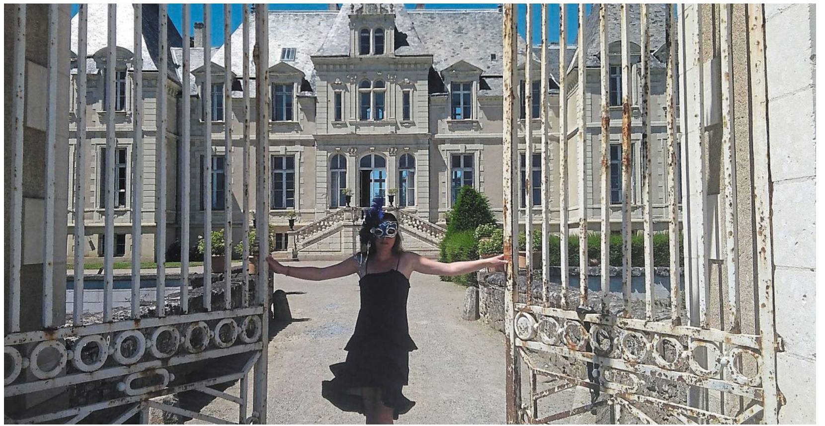
Le château de Vair, propriété de Daphné et Baudouin Allizon depuis 2011, au moment de sa réouverture au public, après le confinement.
